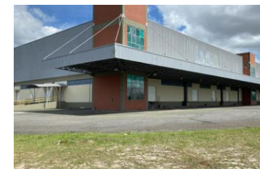
Pintura do galpão Praia do Forte
