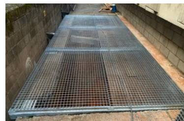
Techo substituído por passarela metálica
