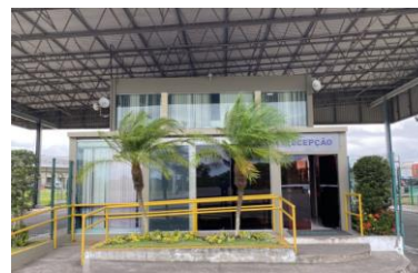
Revitalização e pintura da portaria
